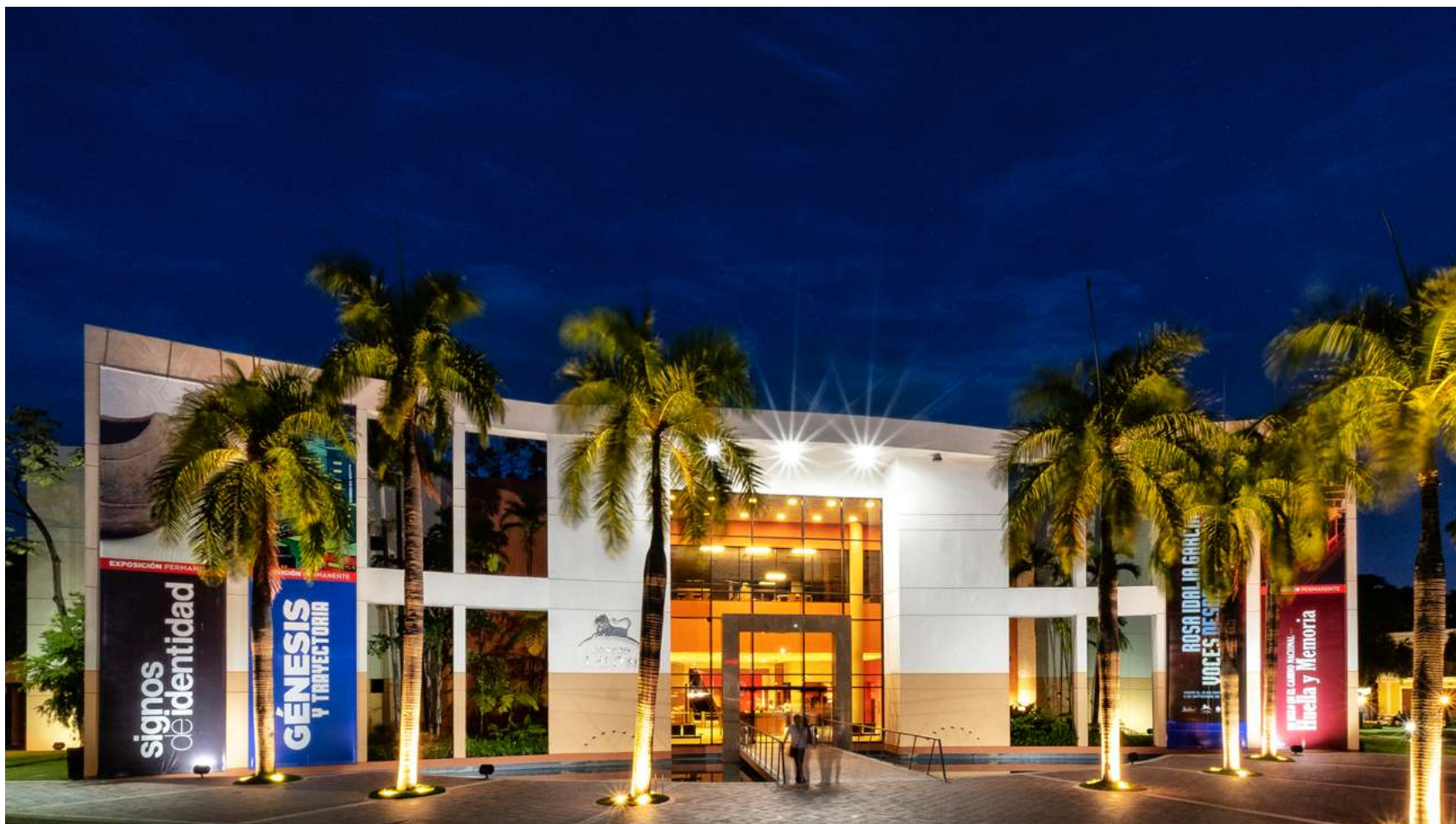
Fachada principal Centro León, Santiago. República Dominicana. Fuente: Centro León.
